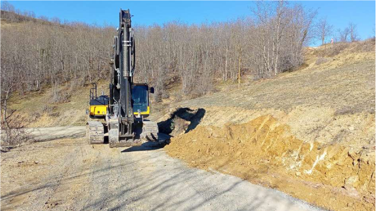
(ULUÇAYIR MAHALLESİ KANAL AÇMA ÇALIŞMASI)
