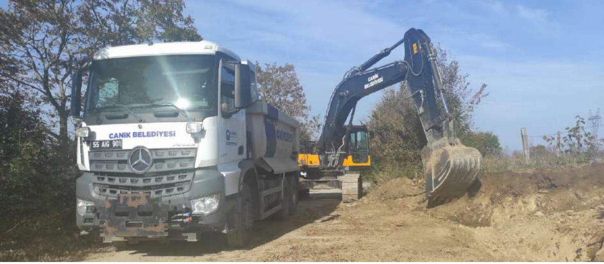
(DÜVECİK MAHALLESİ KANAL AÇMA ÇALIŞMASI)
