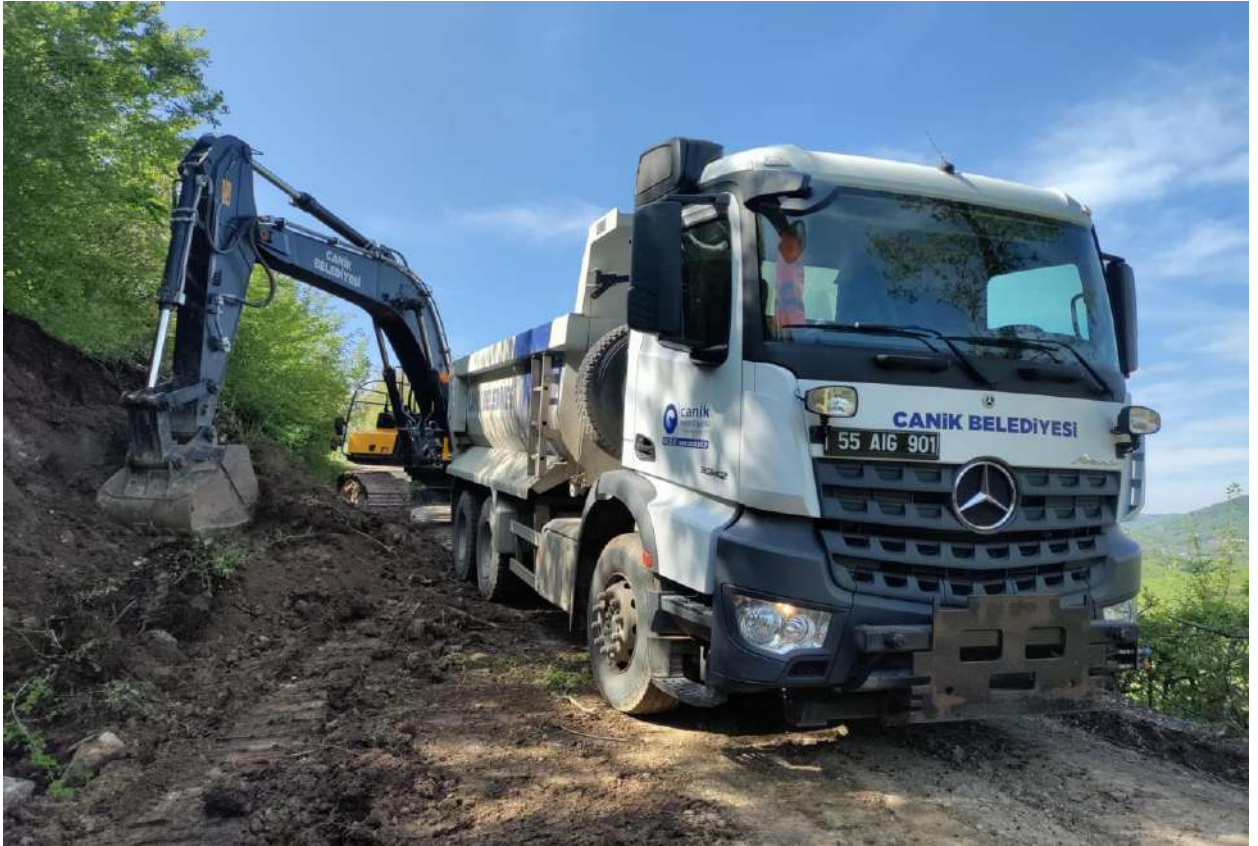
(DÜZARDIÇ MAHALLESİ YOL GENİŞLETME ÇALIŞMASI)
