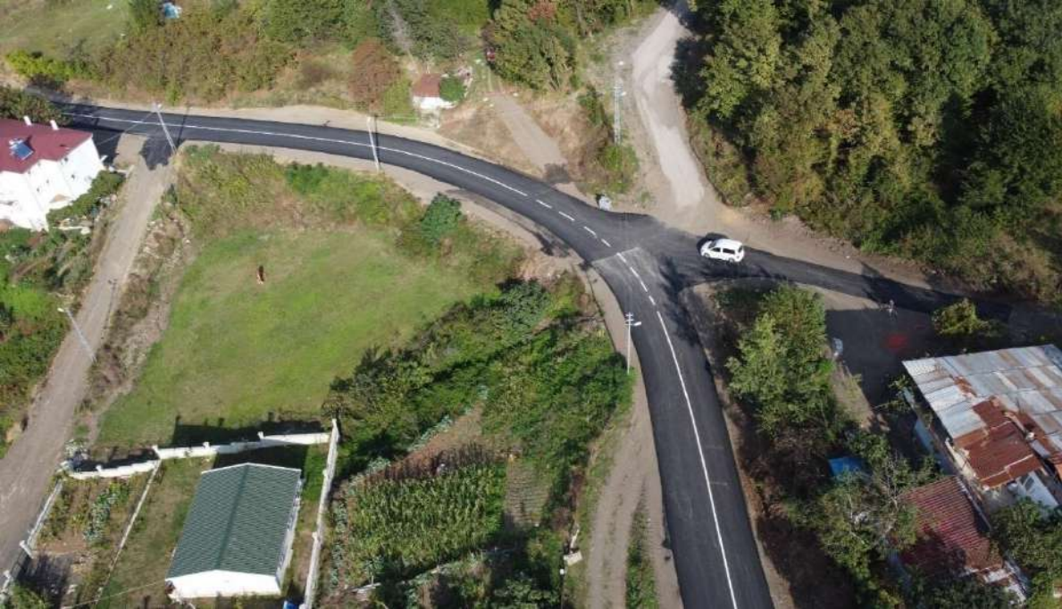
(TEKNEPİNAR MAHALLESİ ASFALT KAPLAMA ÇALIŞMASI)
