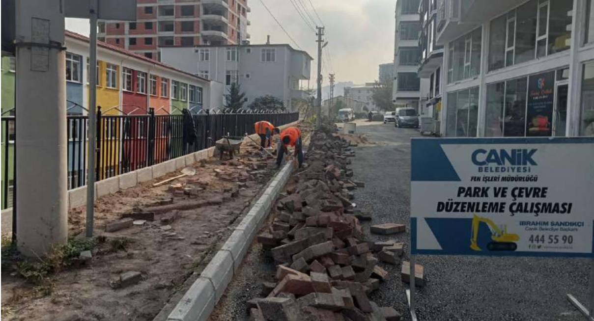
(HASKÖY MAHALLESİ KALDIRIM ÇALIŞMASI)
