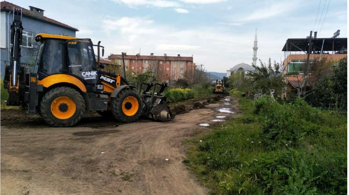
(DÜVECİK MAHALLESİ YOL GENİŞLETME ÇALIŞMASI)
