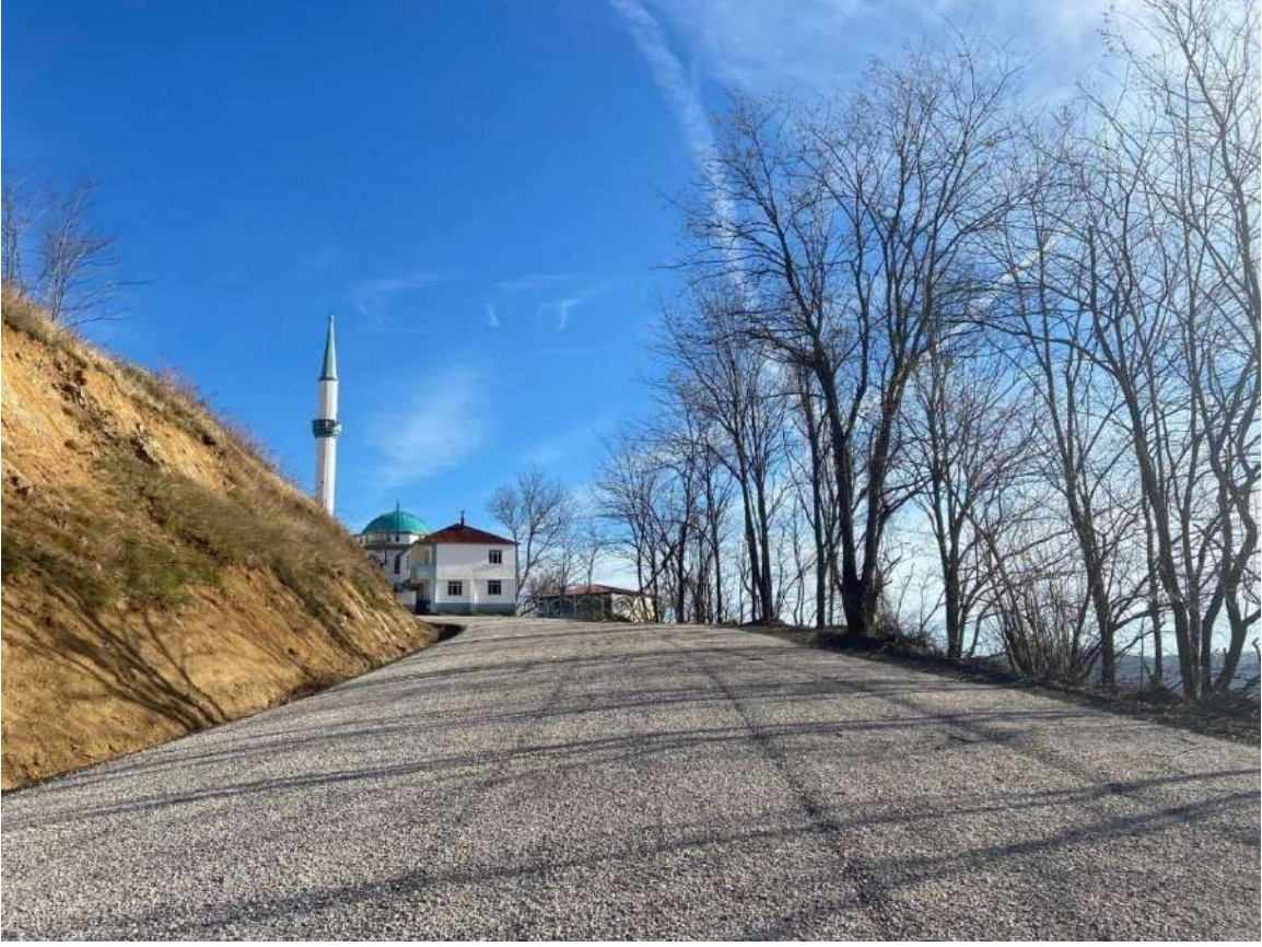
(KESTANEPINAR MAHALLESİ SATHİ KAPLAMA ÇALIŞMASI)
