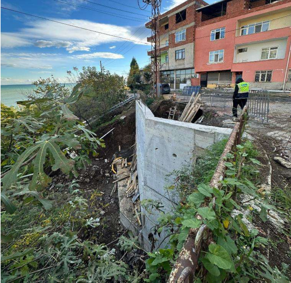
(DERBENT MEVKİİ BETONARME İSTİNAT DUVARI ÇALIŞMASI)
