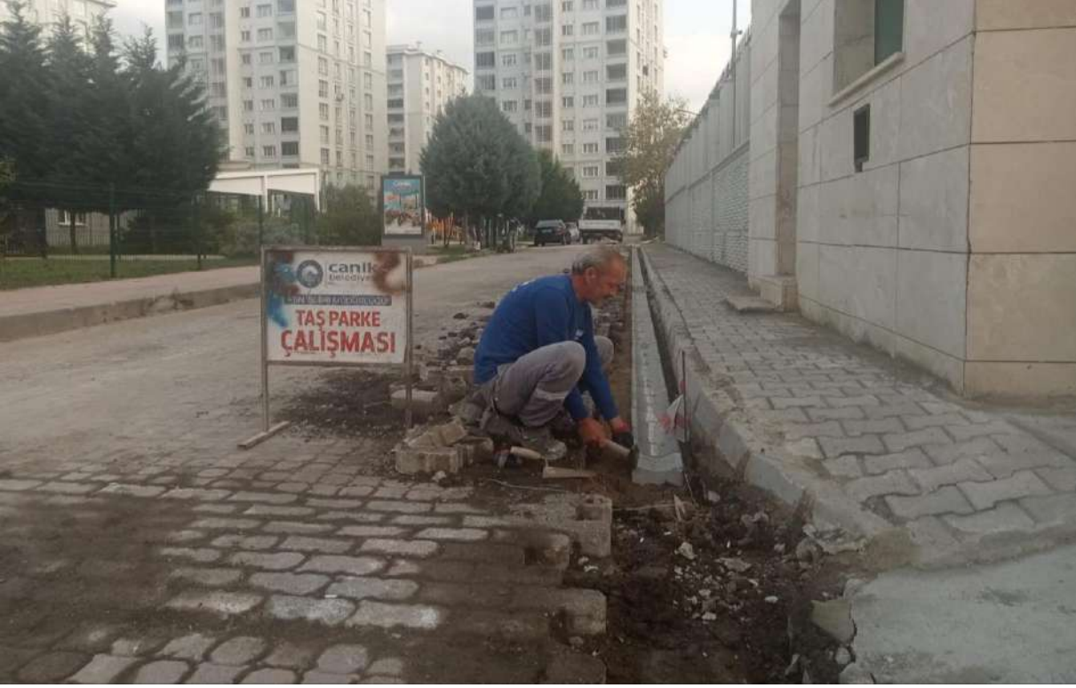
(KUZEY YILDIZI MAHALLESİ OLUK İMALAT ÇALIŞMASI)
