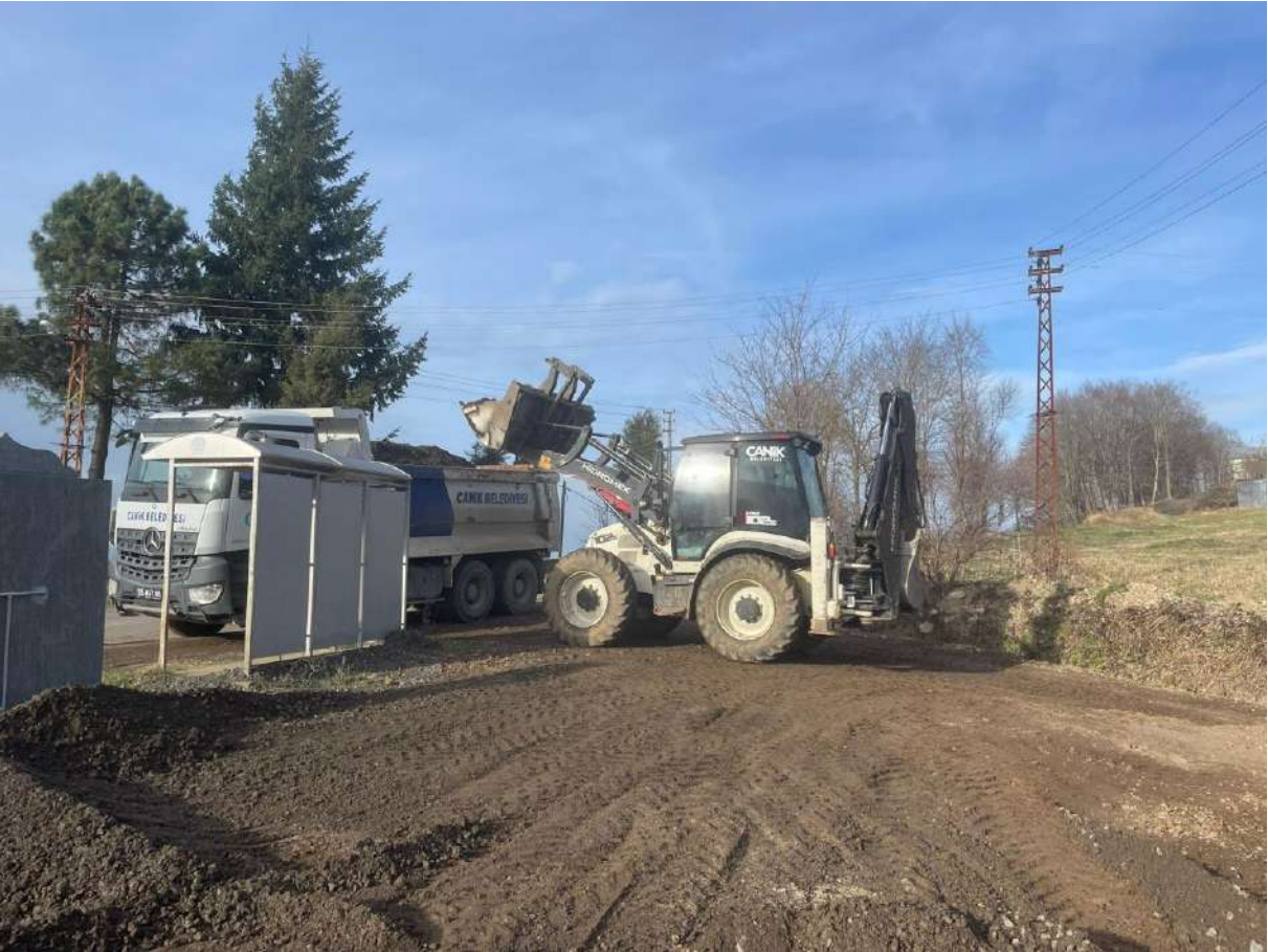
(GÖKÇEPINAR MAHALLESİ ELEKALTI MALZEME SERİM ÇALIŞMASI)
