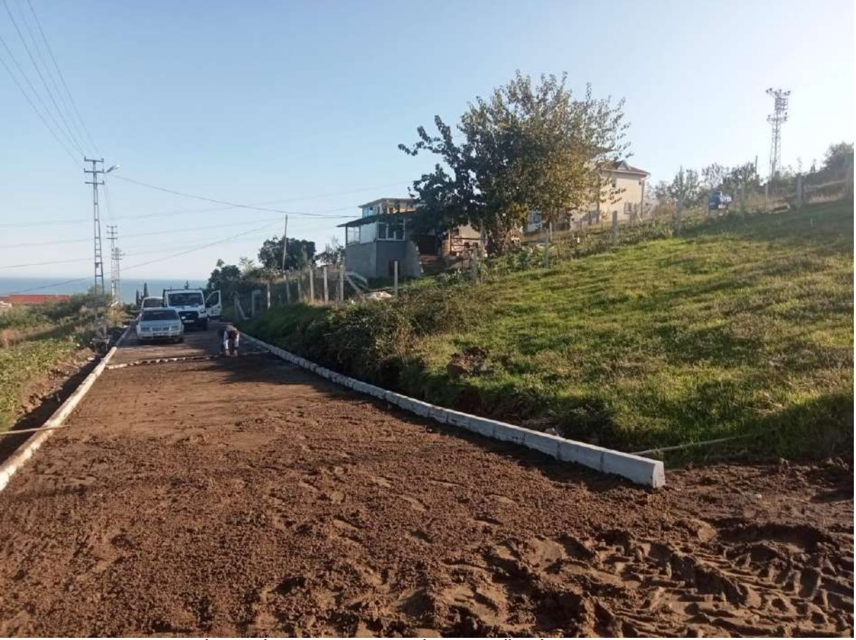
(HACİİSMAİL MAHALLESİ BORDÜR İMALAT ÇALIŞMASI)
