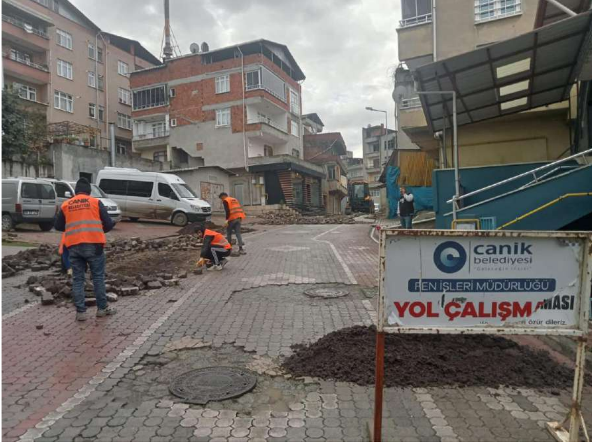
(GAZİOSMANPAŞA MAHALLESİ PARKE TADİLAT ÇALIŞMASI)
