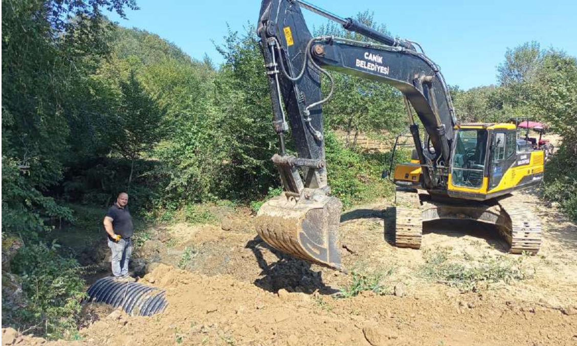
(AMBARPINAR MAHALLESİ KORUGE BORU DÖŞENMESİ)
