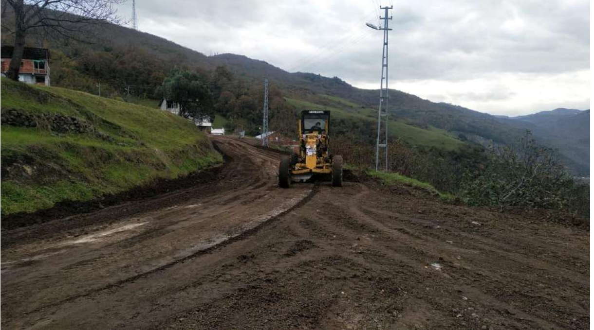
(TEKNEPINAR MAHALLESİ YOL TESVİYE ÇALIŞMASI)
