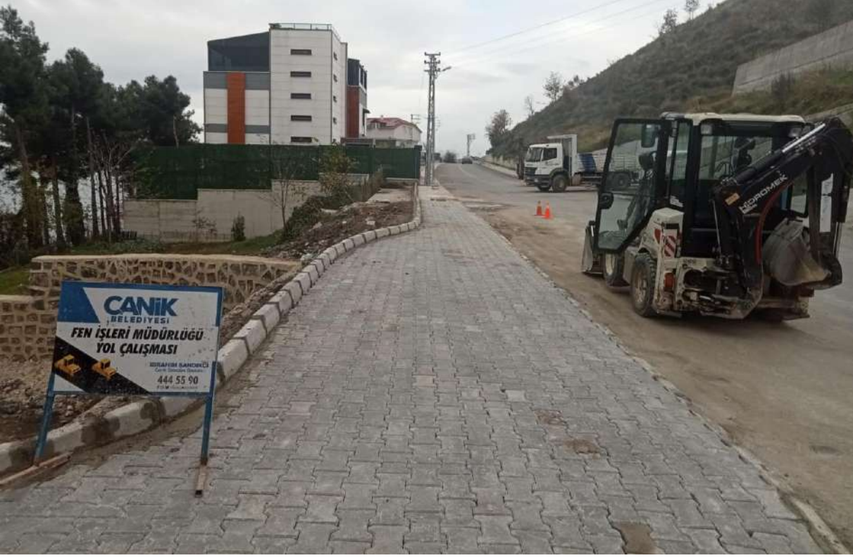
(TOPEPE MAHALLESİ KALDIRIM ÇALIŞMASI)
