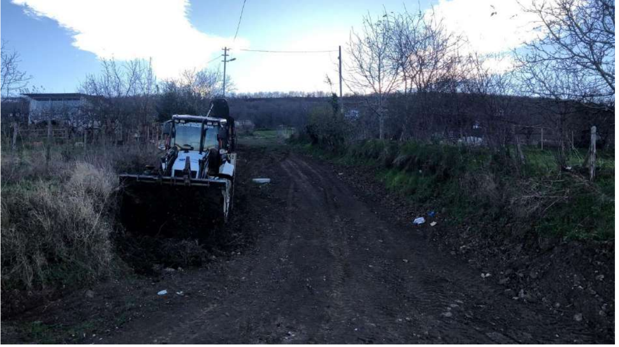
(TEKNEPINAR MAHALLESİ KANAL AÇMA ÇALIŞMASI)
