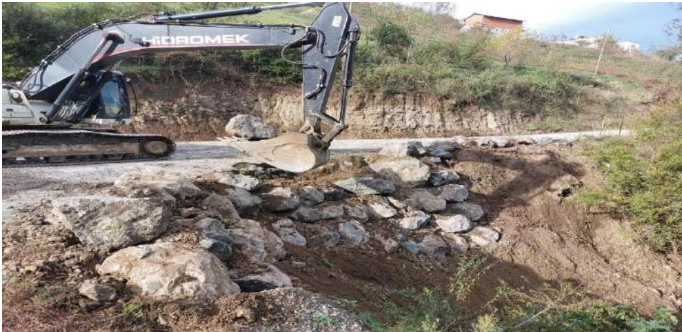
(KAŞYAYLA MAHALLESİ TAŞ TAHKİMAT ÇALIŞMASI)
