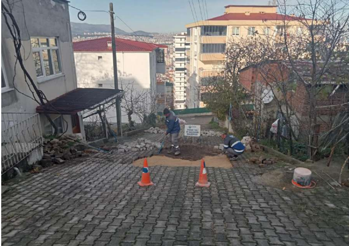
(HASKÖY MAHALLESİ PARKE TADİLAT ÇALIŞMASI)
