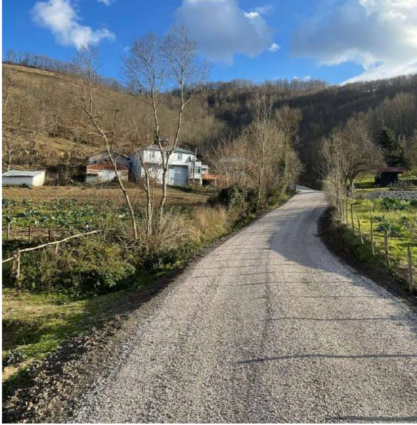
(ÇAĞLAYAN MAHALLESİ SATHİ KAPLAMA ÇALIŞMASI)
