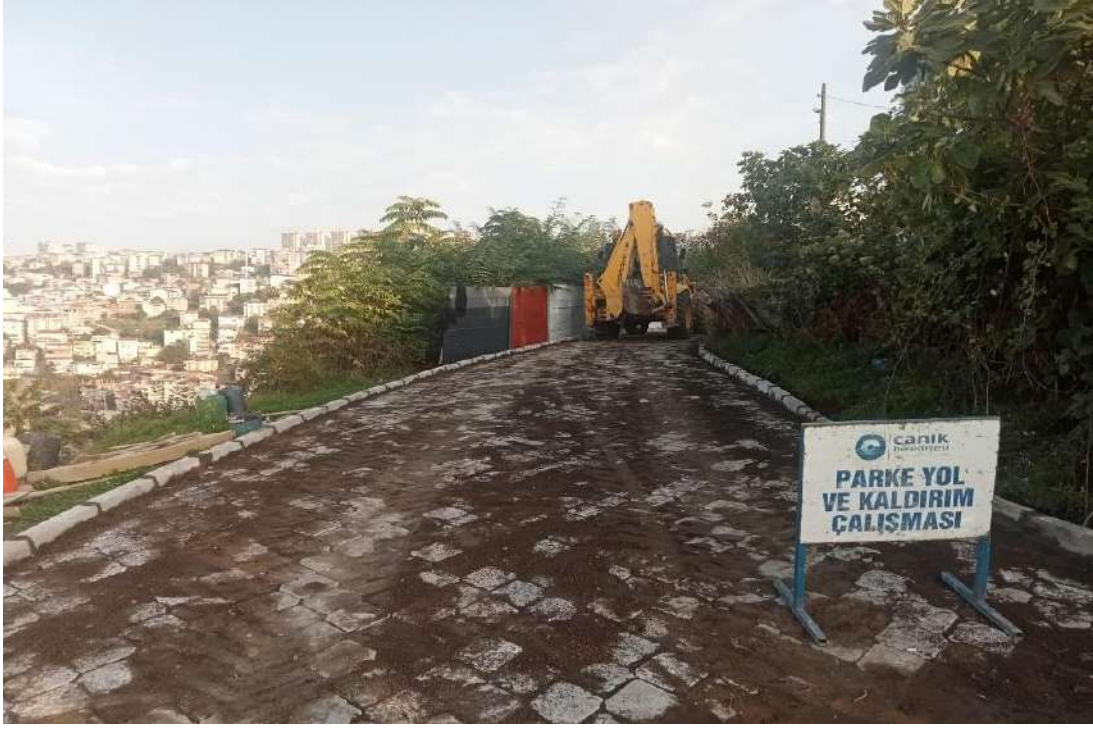
(HACİİSMAİL MAHALLESİ PARKE İMALAT ÇALIŞMASI)
