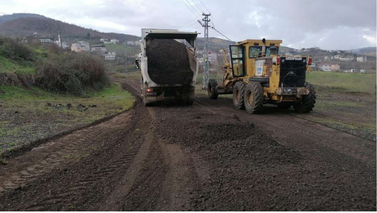
(DERELER MAHALLESİ ELEKALTI MALZEME SERİM ÇALIŞMASI)
