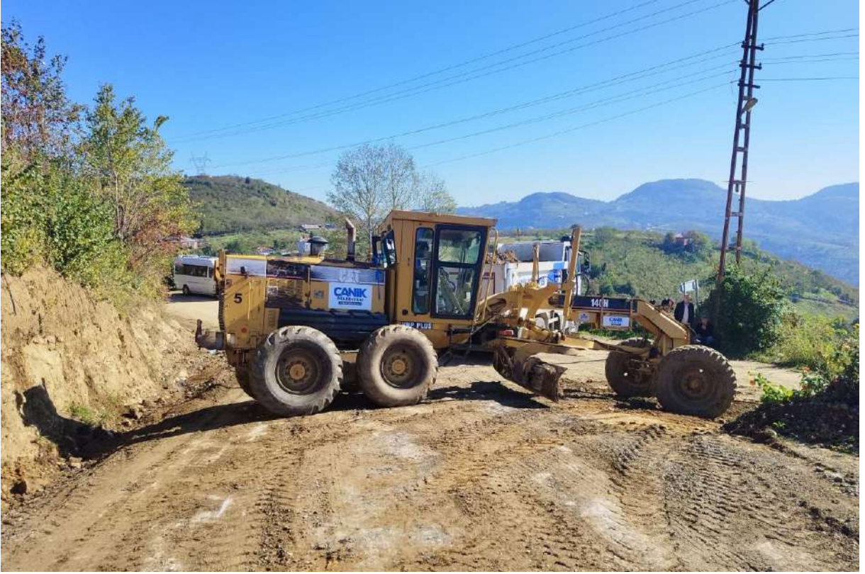
(KESTANEPINAR MAHALLESİ YOL TESVİYE ÇALIŞMASI)
