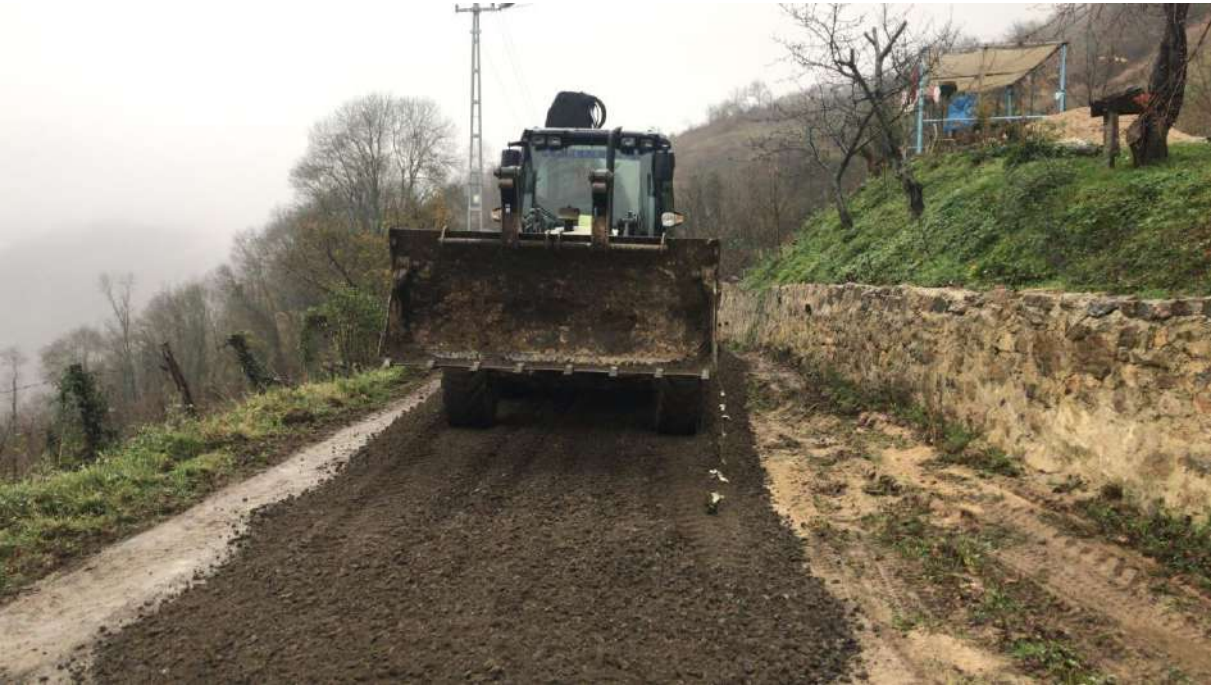
(ÜÇPİNAR MAHALLESİ ELEKALTI MALZEME SERİM ÇALIŞMASI)
