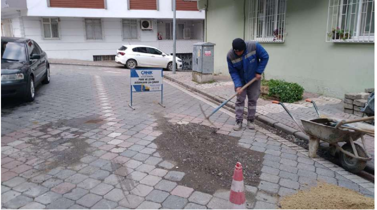
(BELEDİYE EVLERİ MAHALLESİ PARKE TADİLAT ÇALIŞMASI)
