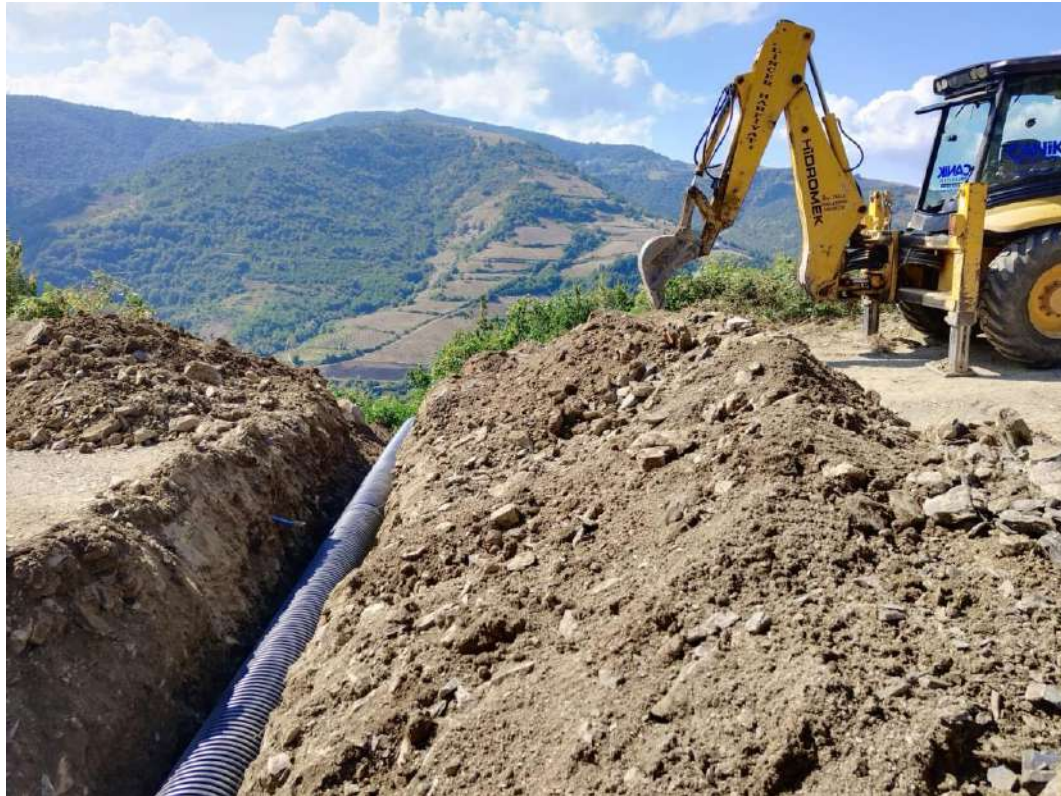
(AVLUCA MAHALLESİ KORUGE BORU DÖŞENMESİ)
