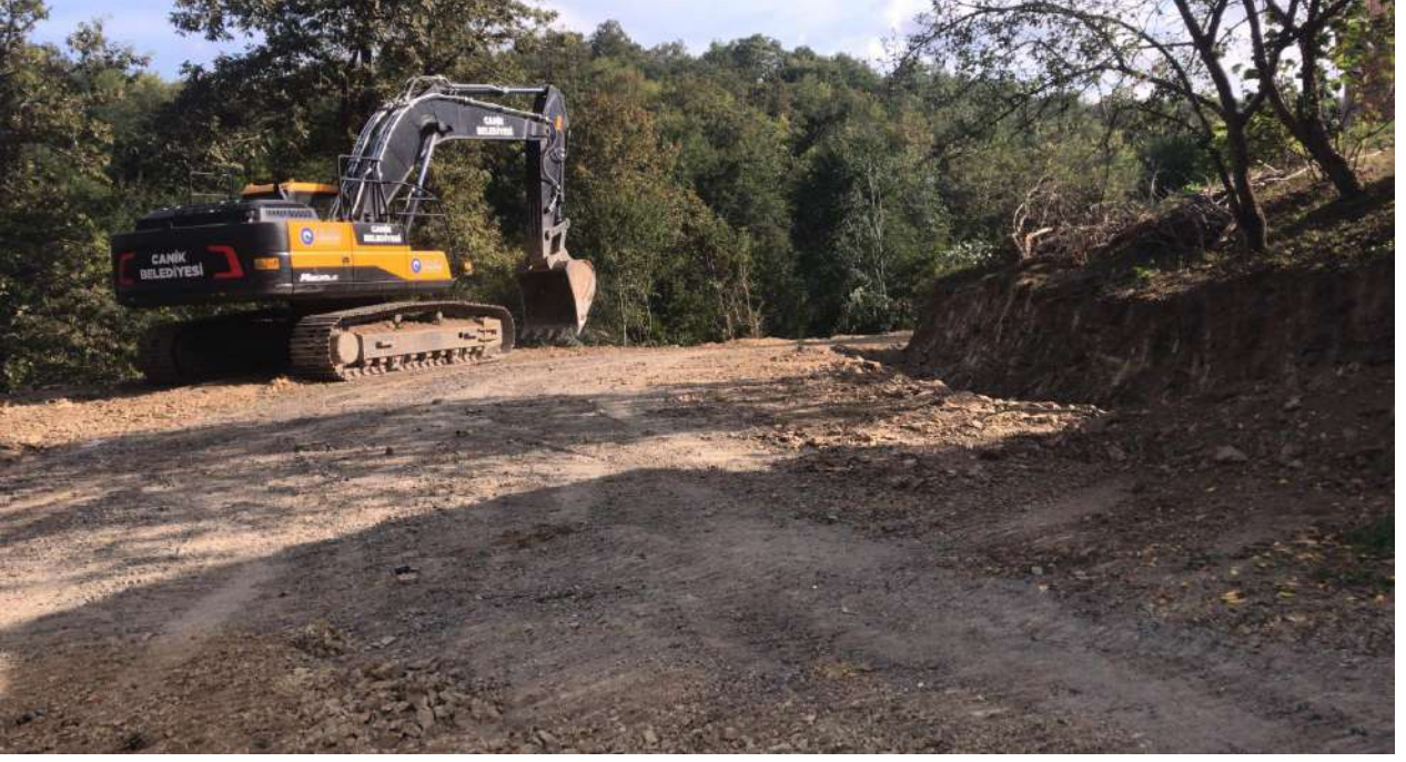
(AMBARPINAR MAHALLESİ YOL GENİŞLETME ÇALIŞMASI)
