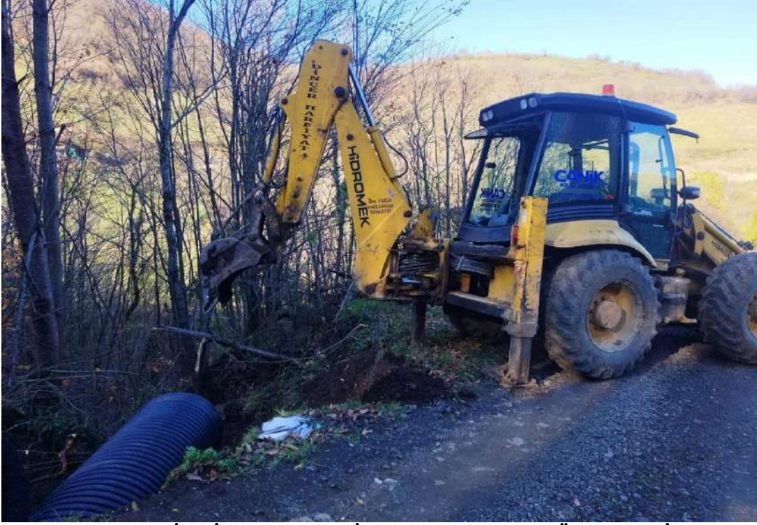
(DEMİRCİ MAHALLESİ KORUGE BORU DÖŞENMESİ)
