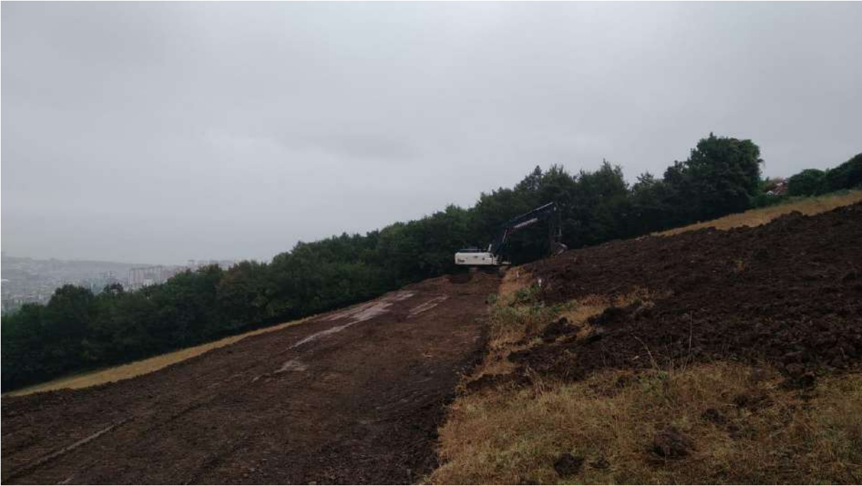
(TEKNEPINAR MAHALLESİ YOL AÇMA ÇALIŞMASI)
