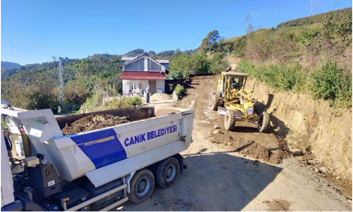
(KESTANEPINAR MAHALLESİ KANAL AÇMA ÇALIŞMASI)
