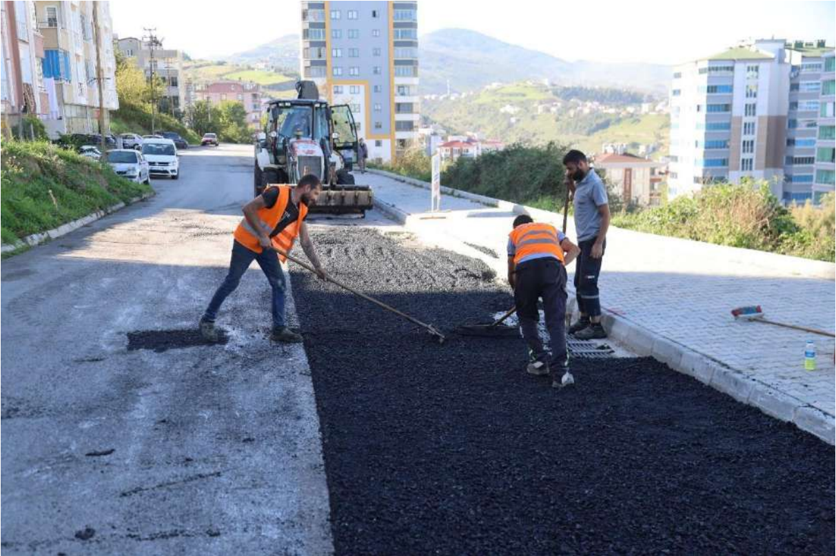
(MUHTELİF YERLER ASFALT YAMA ÇALIŞMASI)
