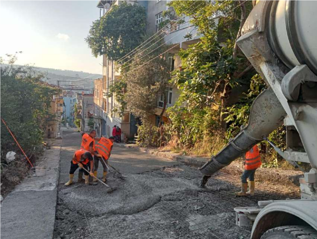
(TOPTPE MAHALLESİ BETON YOL ÇALIŞMASI)
