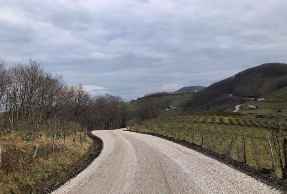
(İMAMLAR MAHALLESİ SATHİ KAPLAMA ÇALIŞMASI)
