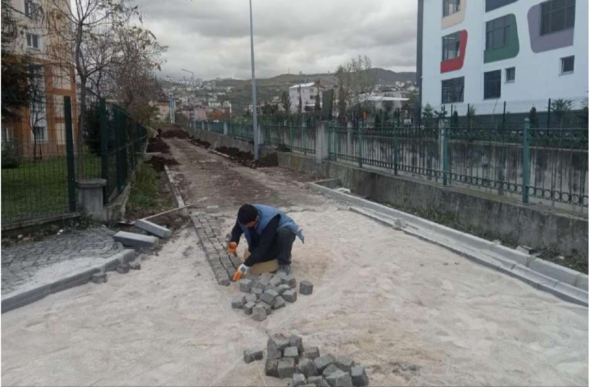
(KUZEY YILDIZI MAHALLESİ KÜP TAŞ İMALAT ÇALIŞMASI)
