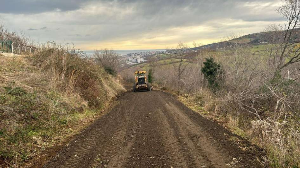
(KOZLU MAHALLESİ ELEKALTI MALZEME SERİM ÇALIŞMASI)
