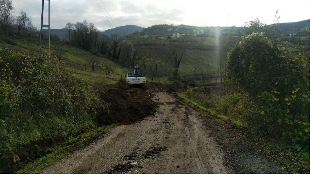
(DERELER MAHALLESİ YOL AÇMA ÇALIŞMASI)
