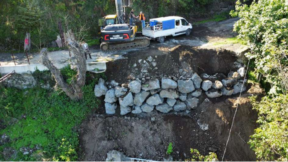
(DÜZARDIÇ MAHALLESİ TAŞ TAHKİMAT ÇALIŞMASI)
