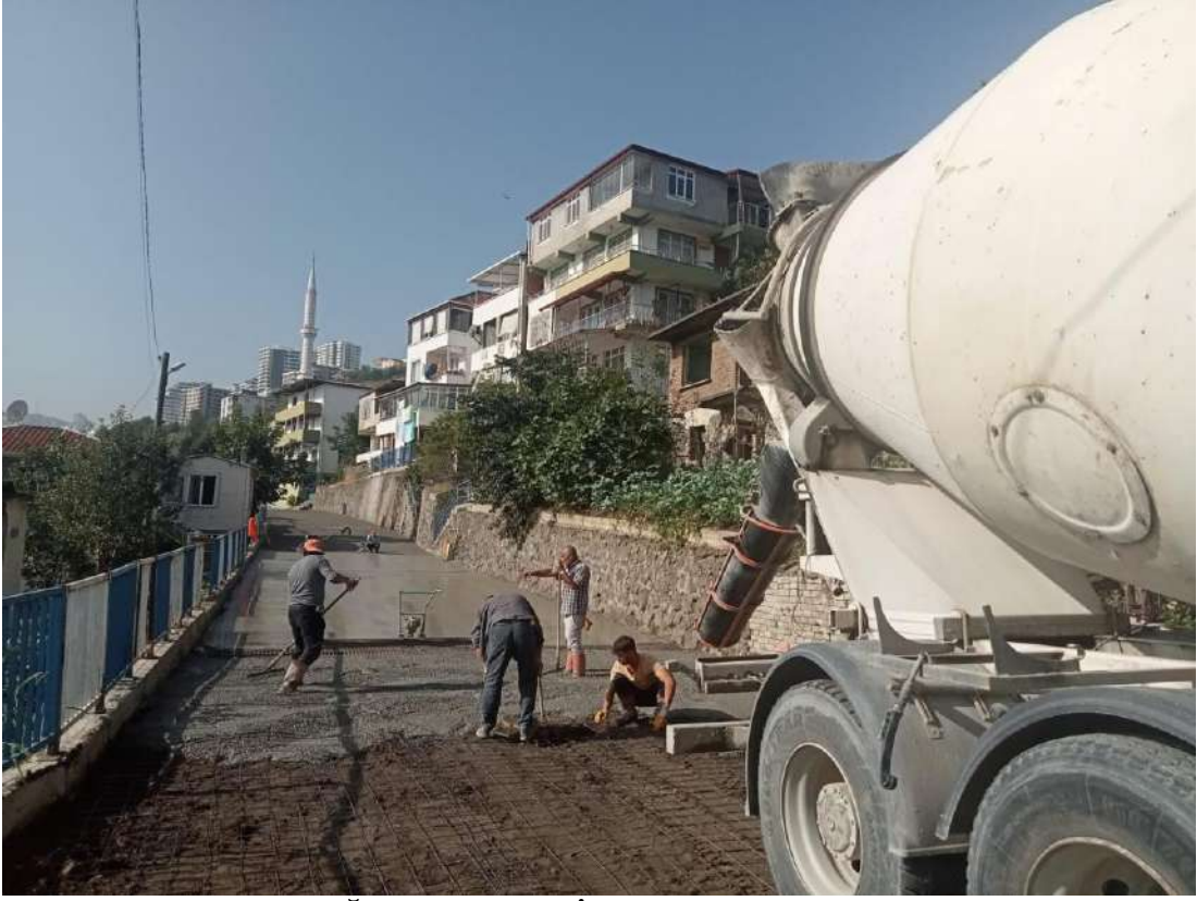
(ULUDAĞ MAHALLESİ BETON YOL ÇALIŞMASI)
