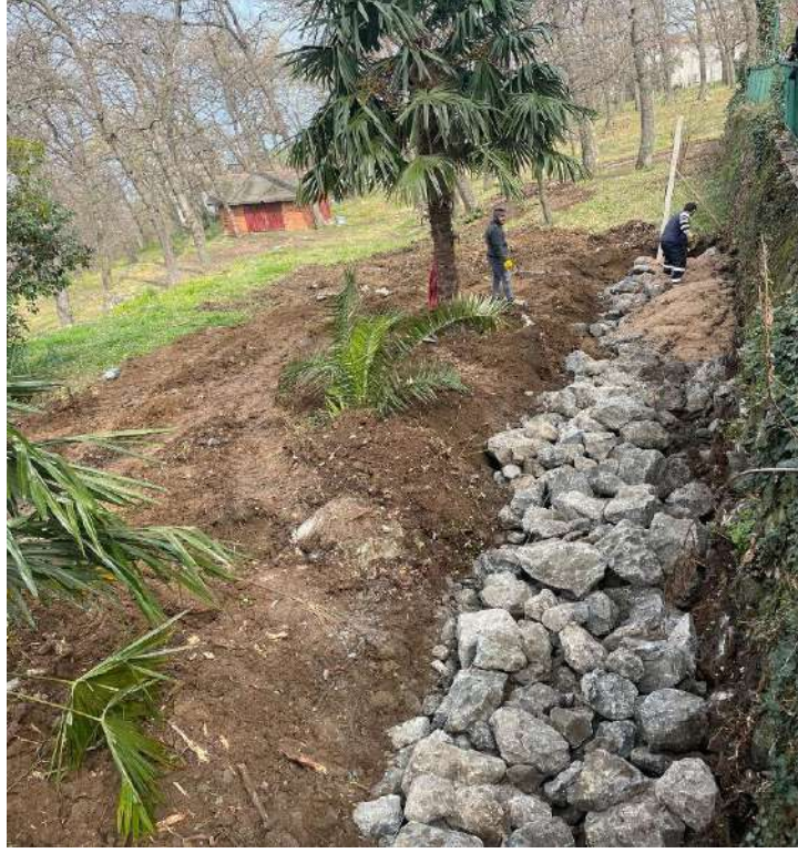
(MEŞE TESİSLERİ TAŞ DUVAR İMALATI)
