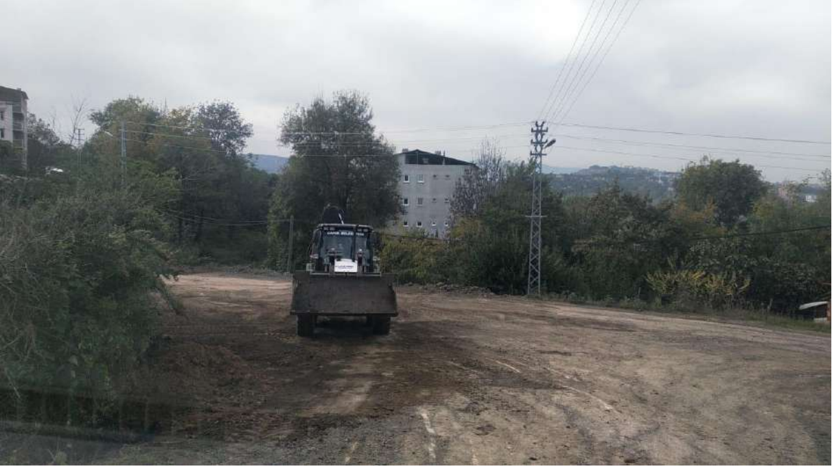
(DERELER MAHALLESİ YOL TESVİYE ÇALIŞMASI)
