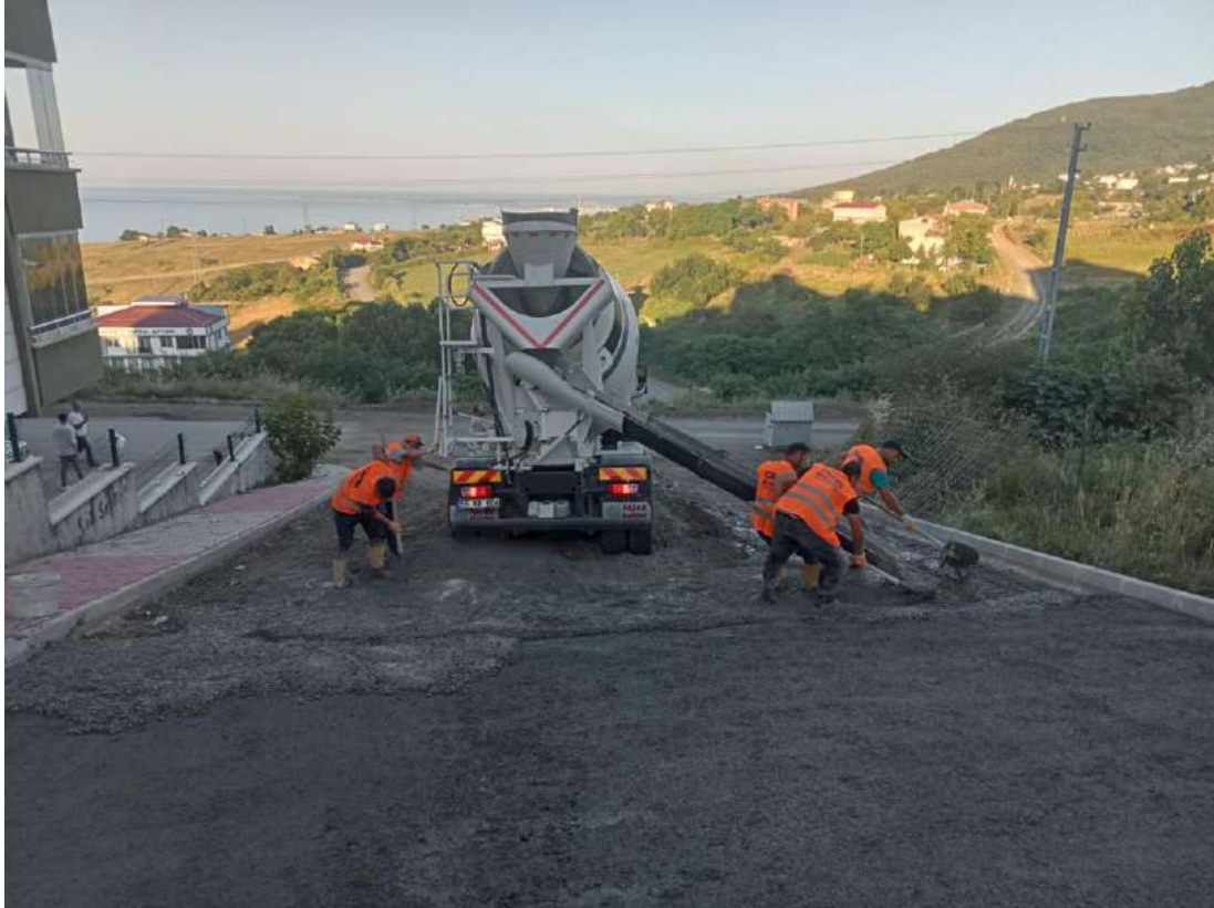
(HASKÖY MAHALLESİ BETON YOL ÇALIŞMASI)
