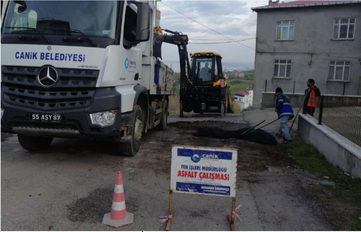
(MUHTELİF YERLER ASFALT YAMA ÇALIŞMASI)
