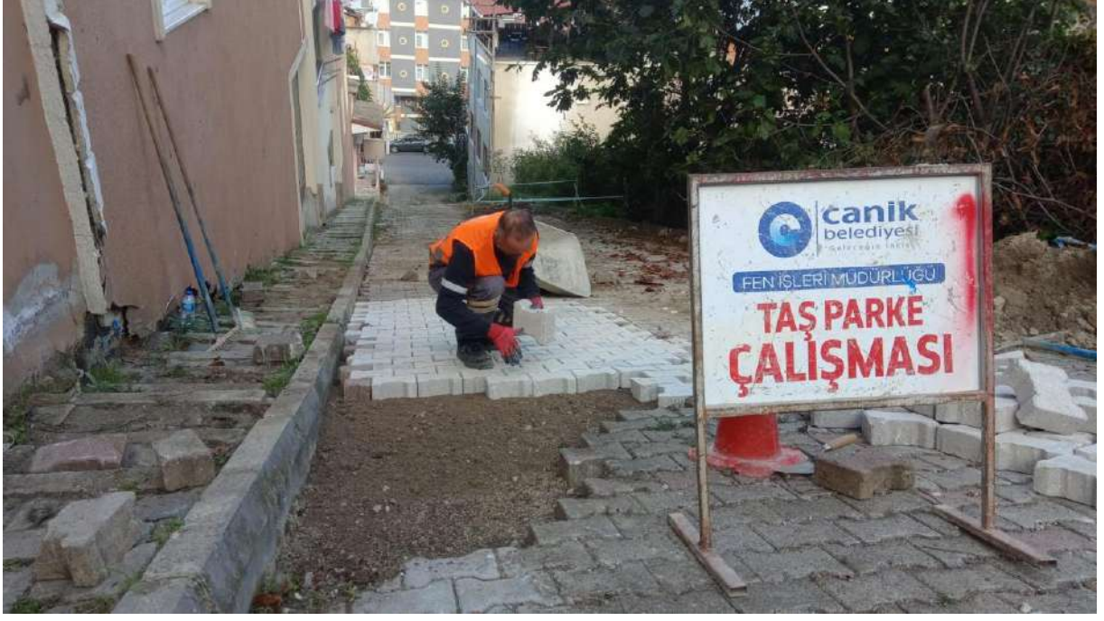
(ULUDAĞ MAHALLESİ PARKE TADİLAT ÇALIŞMASI)
