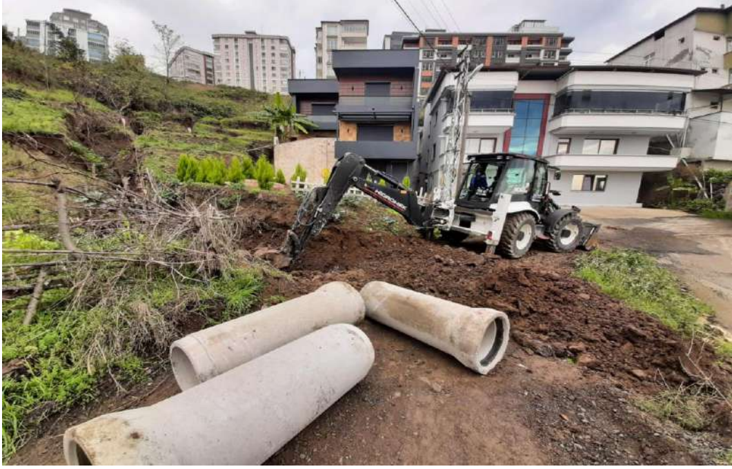
(TOPTETEPE MAHALLESİ BETON BÜZ DÖŞENMESİ)
