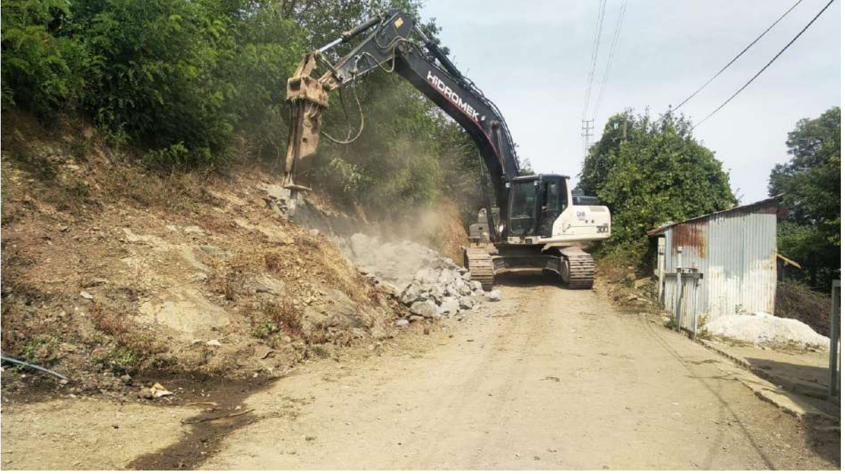
(GÜRGENYATAK MAHALLESİ YOL GENİŞLETME ÇALIŞMASI)
