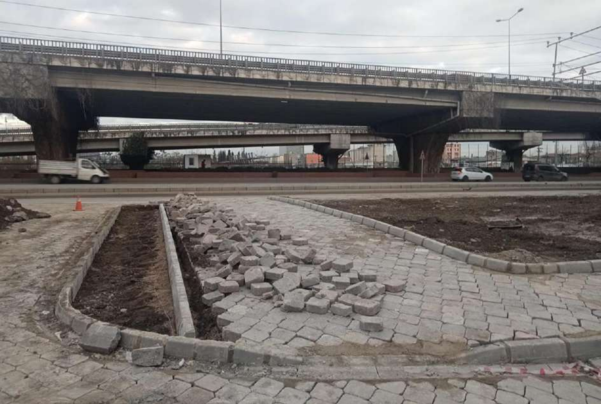
(KARŞIYAKA MAHALLESİ KALDIRIM ÇALIŞMASI)
