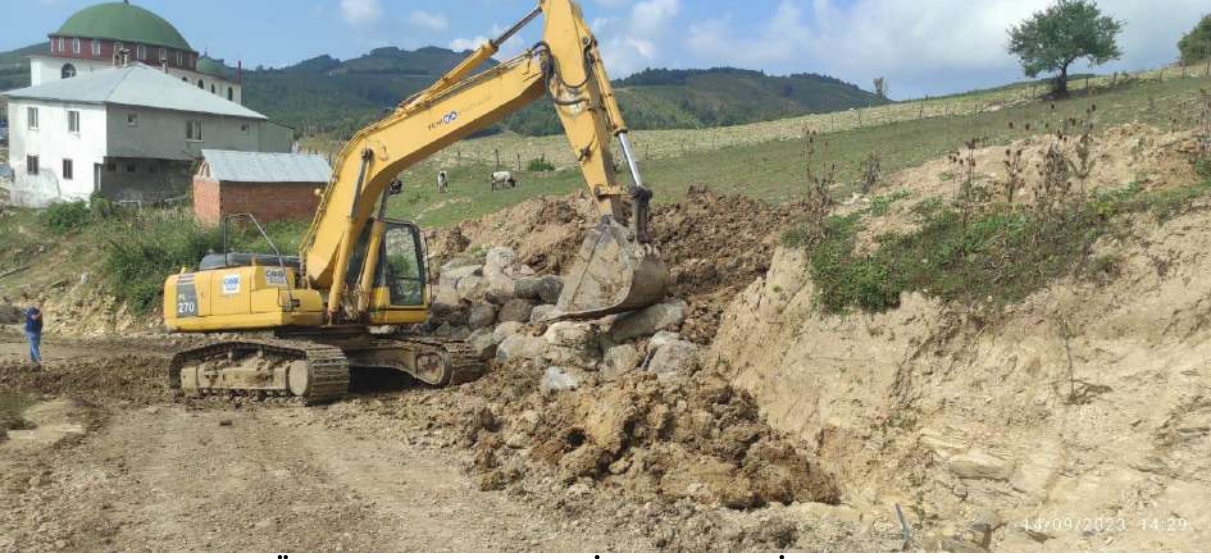
(GÜLTEPE MAHALLESİ TAŞ TAHKİMAT ÇALIŞMASI)
