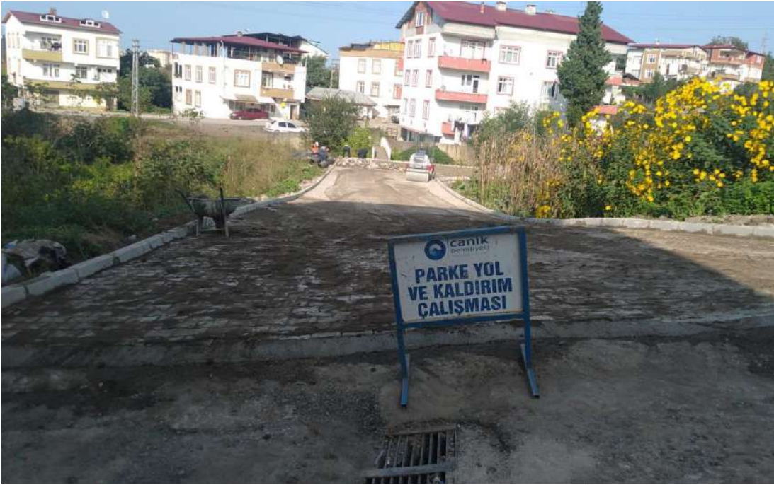
(DÜVECİK MAHALLESİ PARKE İMALAT ÇALIŞMASI)
